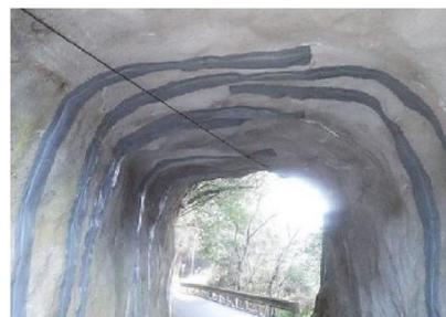
図-10 線導水 施工イメージ
