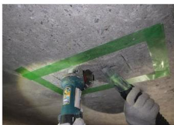
図-11 コンクリートカッター 施工イメージ
