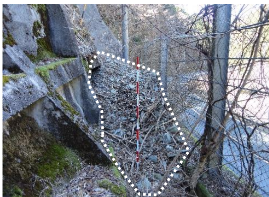
図-3 落石・土砂の堆積状況
