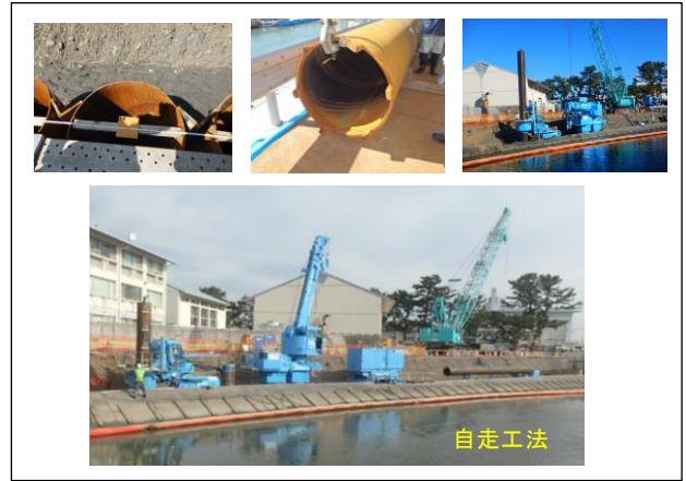
写真 2.3 左岸鋼管矢板施工写真
