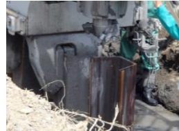
写真 2.1 鋼矢板圧入写真
