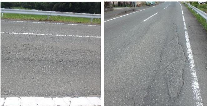
写真-1 ひび割れの状況写真
