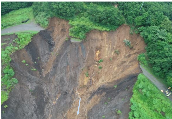
図-3、4 崩壊地源頭部の画像
