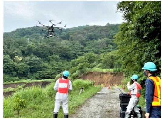
図-7 UAVレーザー計測
