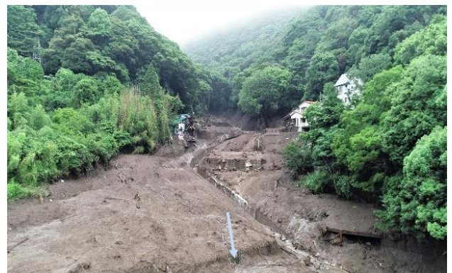
図-6 市道伊豆山神社線上流部堆砂状況
