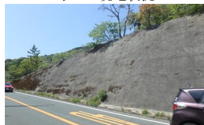
写真-2 現地状況
