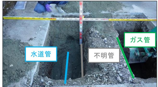
図-4 試験掘削状況
