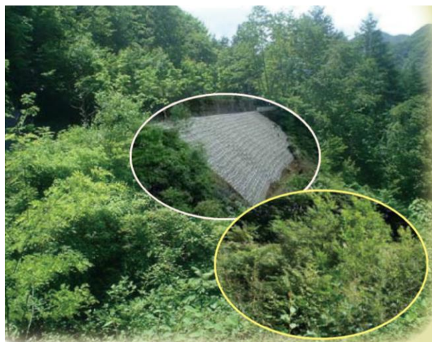
写真-2 のり面緑化の施工事例
