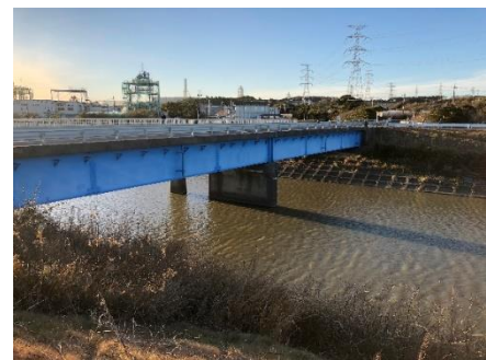
写-1 非出水期における小塩橋の水位状況
