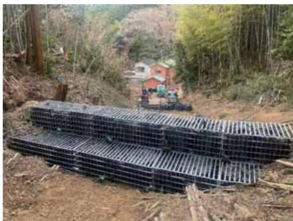
図-4 完成した応急土石流ガード
