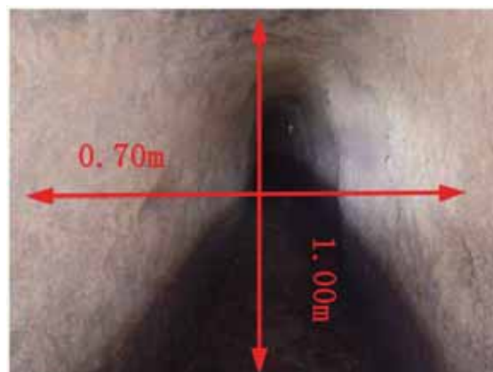
図－ 3 隧道内の状況写真（縦1.00m横0.70m）
