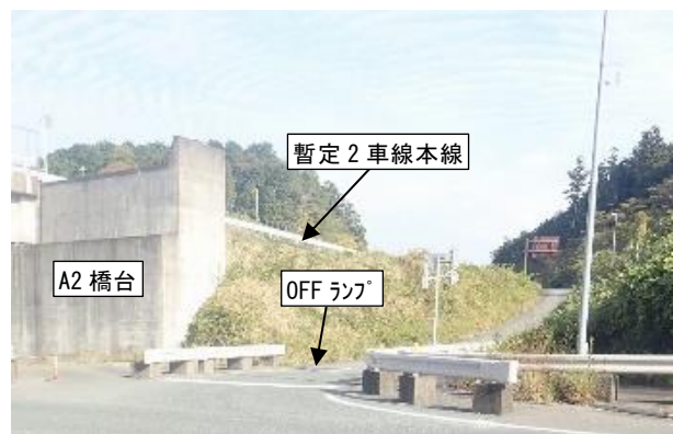
写真-1 現況状況(起点側)
