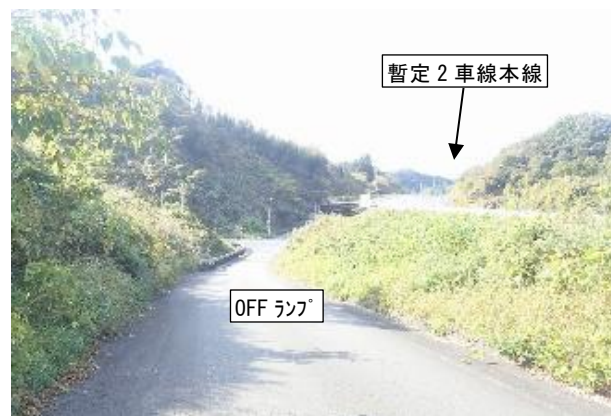
写真-2 現況状況(終点側)
