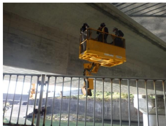
図-5 浜川大橋点検風景
