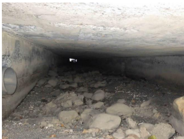
図-3 小黒橋桁下状況
