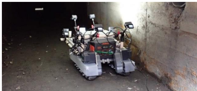
図-9 小黒橋点検風景
