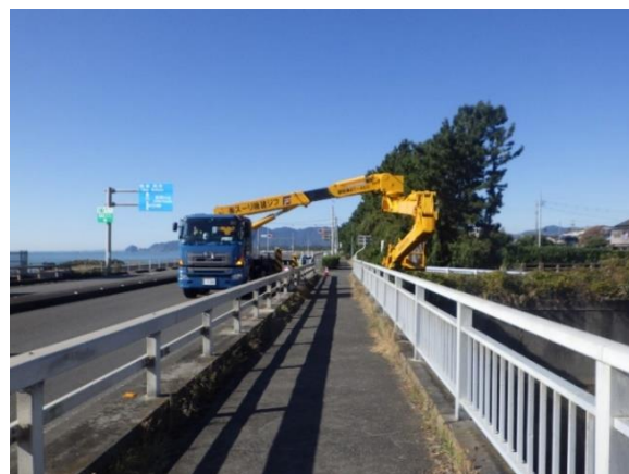
図-4 潮騒橋点検風景
