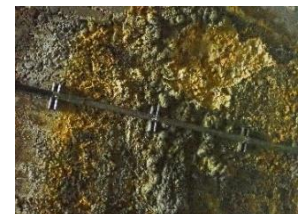
図-3 黄褐色変色箇所
