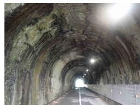
図-2 覆工全体状況
