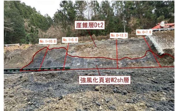
図-5 床掘面地質状況
