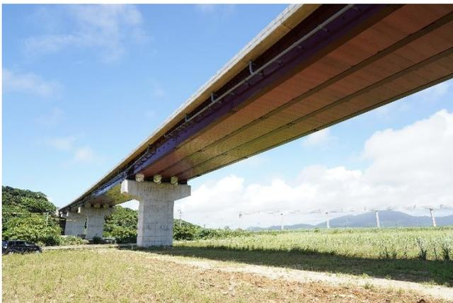
図－5 桁間防護板の事例（沖縄）
