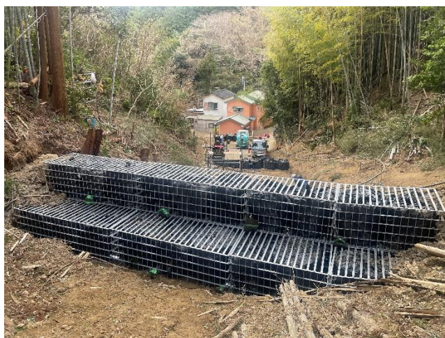
図-4 完成した応急土石流ガード
