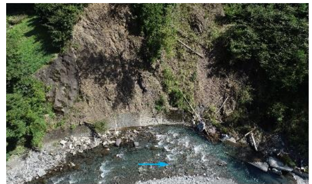
図-3 設計対象箇所：UAV 撮影写真
