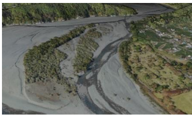
図-11 樹木繁茂状況
