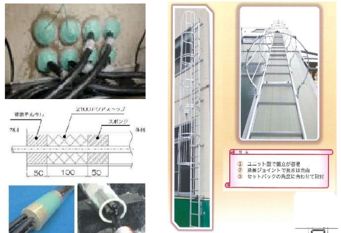
写真-7：スリーブ埋設
