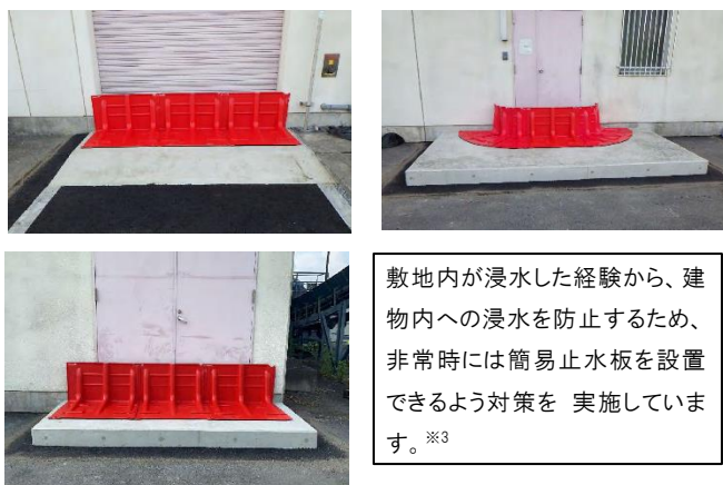
写真-9：簡易止水版による対策
