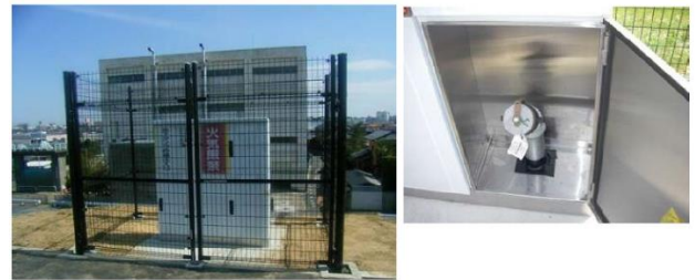
写真-6：給油口の高所化事例（古ヶ崎排水機場）
