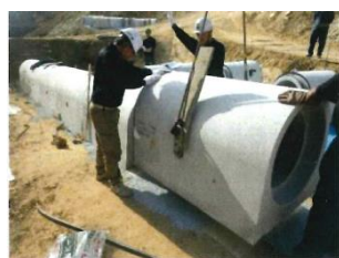
図-12 底樋据付の様子
