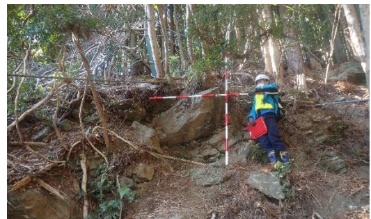
図4 従来の現場作業時の様子
