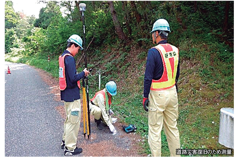
道路災害復旧のため測量
