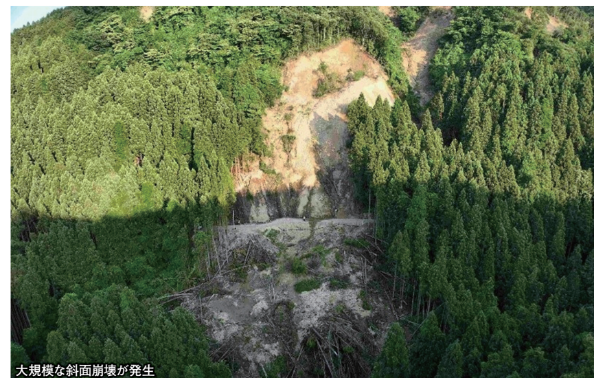
大規模な斜面崩壊が発生
