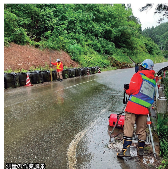
測量の作業風景
