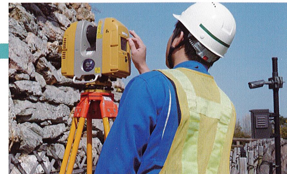
地上型レーザスキャナ計測風景
